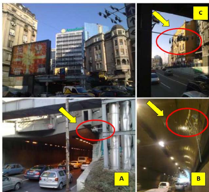
Slika 63. Mahovina u vrećicama izložena utjecaju onečišćenja ujućih tvari iz prometa na mjestu ulaza u tunel (A), u samom tunelu (B) i na izlazu iz tunela (C) 183
