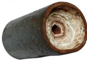
Slika 15. Cijev zapunjena kamencem
