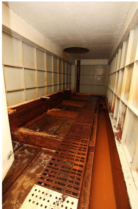
Slika 14. Spremnik za aeraciju i taloženje željeza
