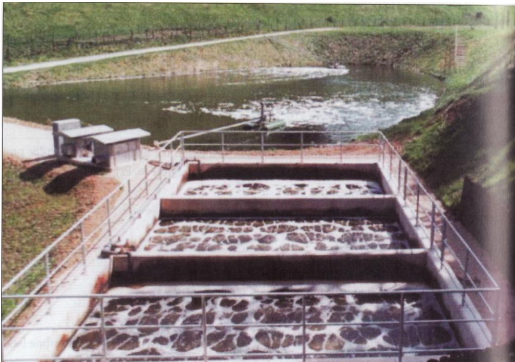
Slika 49. Reaktor za nitrifikaciju
