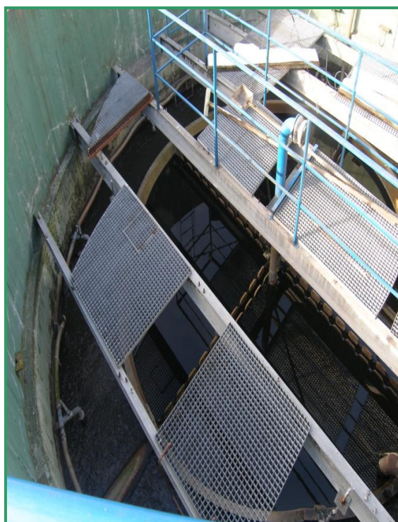
Slika 48. Naknadni taložnik u ljevaonici Lipovica d.o.o.
